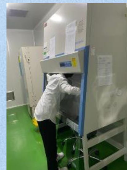
Proses Penggantian Lampu Neon pada Biosafety Cabinet
